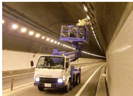
【通行止めによるトンネル内の点検】
